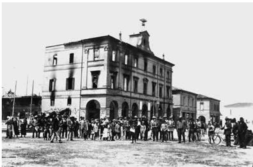
Alfonsine. Gruppo di rivoltosi di fronte al municipio incendiato
